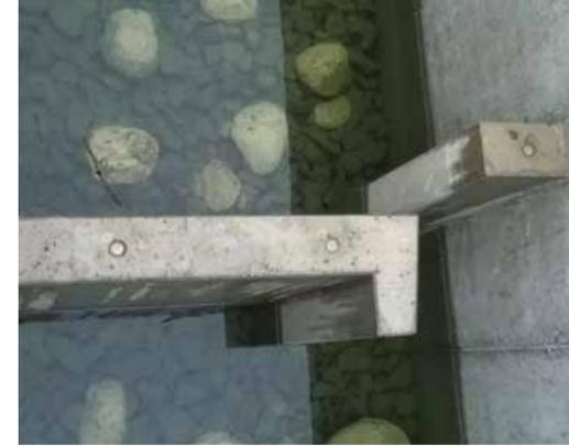
Die Zwischenwände sind mit einem hakenförmig gestalteten Vorsatz versehen, der eine Strömungsumlenkung im Bereich vor der Schlitzöffnung bewirkt. Die wandseitige Schlitzbegrenzung erfolgt mit einem versetzt angeordneten Umlenckblock. Das Versatzmaß des Umlenckblockes erzeugt eine um den Winkel abgelenkte Schlitzströmung, sodass sich eine in Beckenmitte verlaufende Hauptströmung einstellt.
