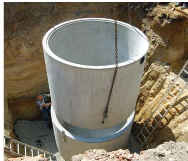
Als Komplettanbieter liefern wir die Pumpwerke auch mit maschineller und elektrischer Ausrüstung. Der Standard Keilbeton ist in der Wanne monolithisch mitgegossen.
